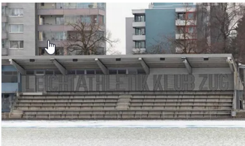
Foto: Tribünenanlage Leichtathletikstadion
